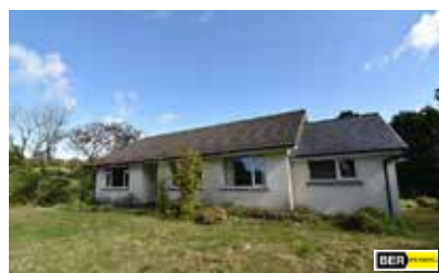
FURZE COTTAGE, BALLYDEHOB €150,000
